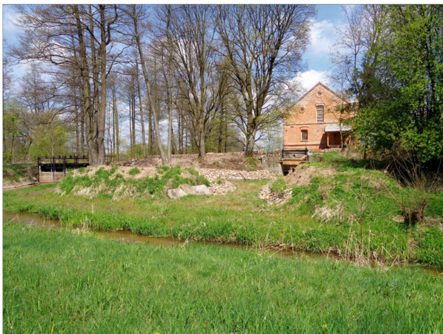
Odrestaurowany młyn z zaporą w Jędrowie; fot. P. Przepióra (2015)
