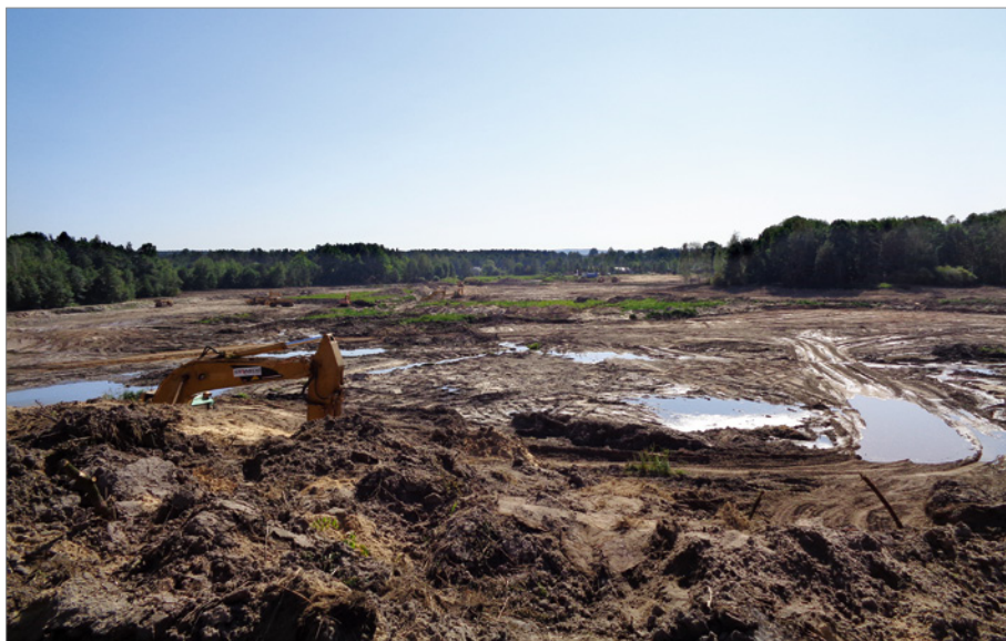
Prace pogłębiające basen Zalewu Suchedniowskiego; fot. P. Przepióra (2017)
